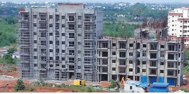
टाइप A1 और A2 कार्टर: A1 समाप्ति कार्य प्रगति पर एवं A2 तीसरे तल का स्लैब पूरा
